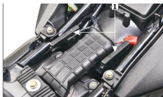
1. Cajas de fusibles
